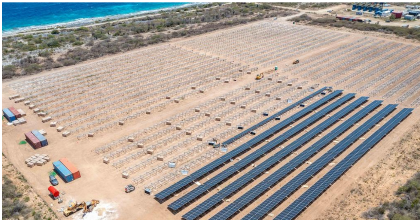
luchtfoto van het zonnepanelenpark in aanbouw
