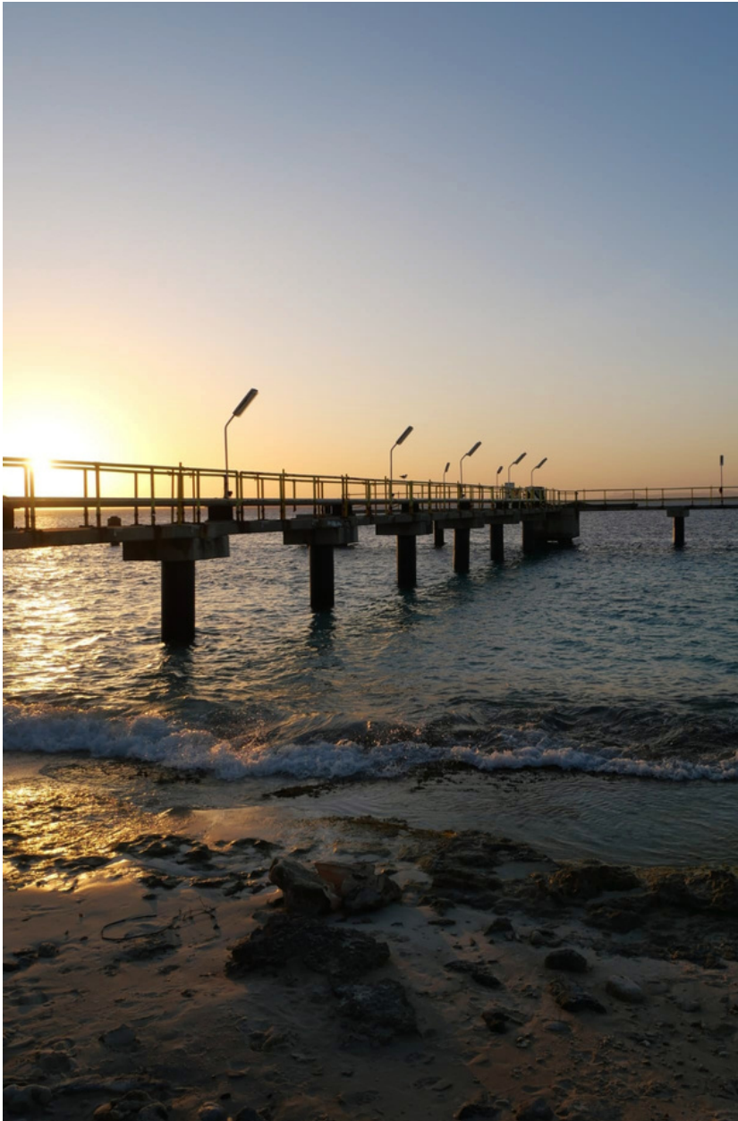
De huidige steiger die gerenoveerd zal worden
